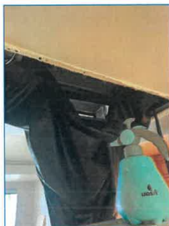
ภาพถ่ายที่ 2.2-23 การทำความสะอาดเครื่องปรับอากาศ
